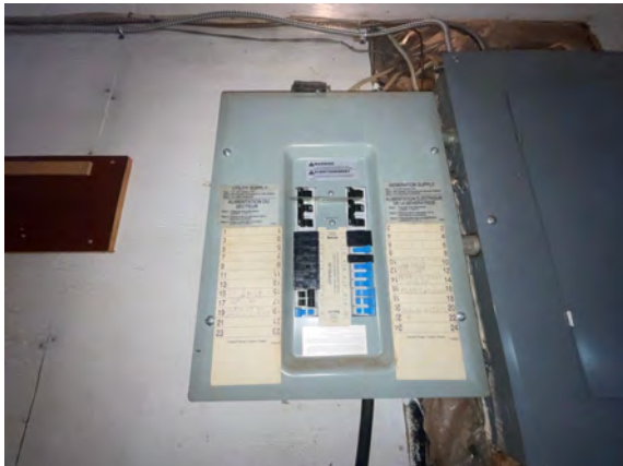
Brudenell Fire Hall #4 - D501025
