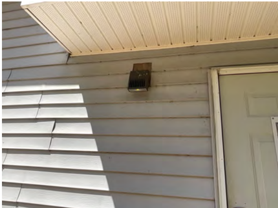
Brudenell Fire Hall #4 - D502041
