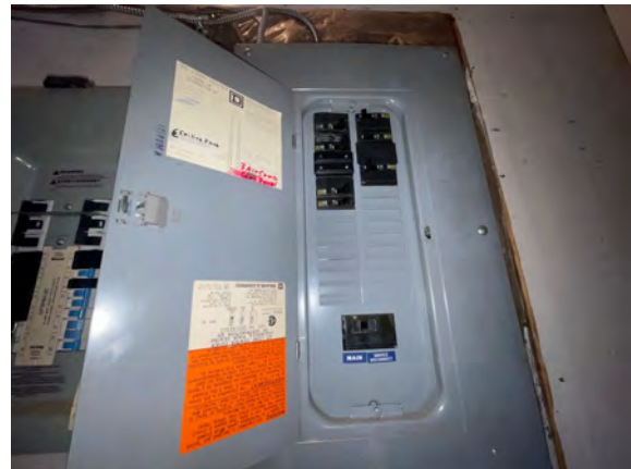
Brudenell Fire Hall #4 - D501003
