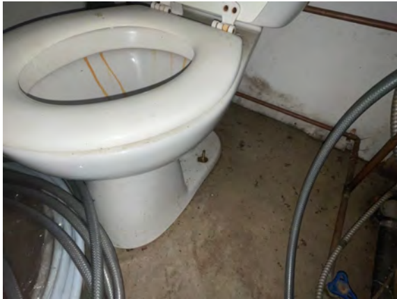
Brudenell Fire Hall #4 - D201001
