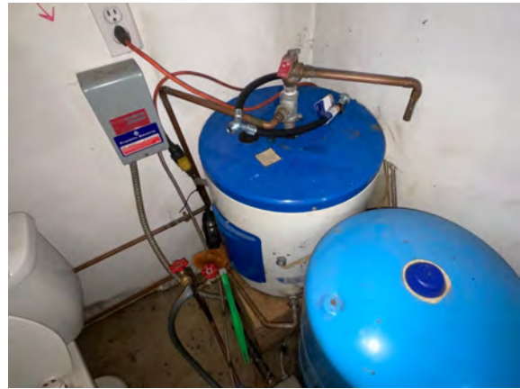
Brudenell Fire Hall #4 - D202034
