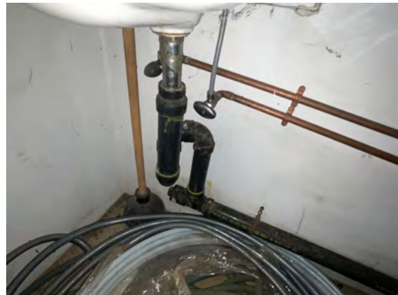
Brudenell Fire Hall #4 - D202001
