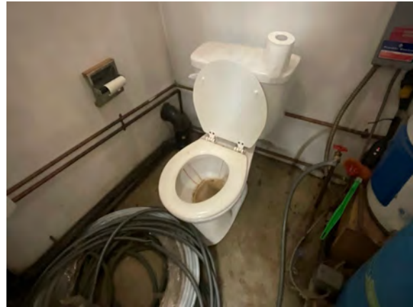
Brudenell Fire Hall #4 - D201001
