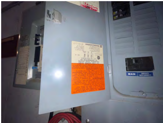
Brudenell Fire Hall #4 - D501003
