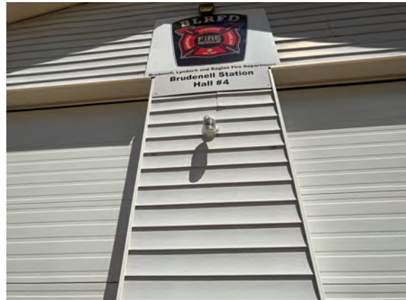
Brudenell Fire Hall #4 - D502041
