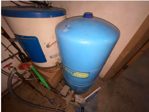
Brudenell Fire Hall #4 - D202021
