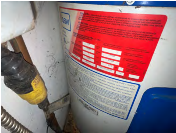
Brudenell Fire Hall #4 - D202034
