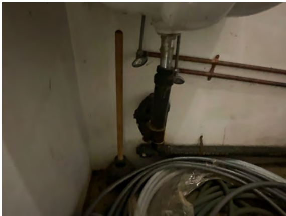
Brudenell Fire Hall #4 - D203001
