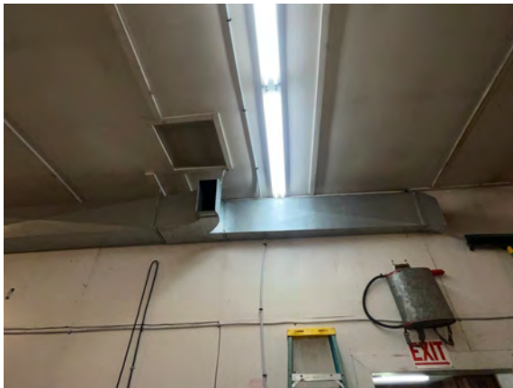
Brudenell Fire Hall #4 - D302003
