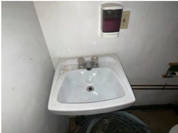
Brudenell Fire Hall #4 - D201003
