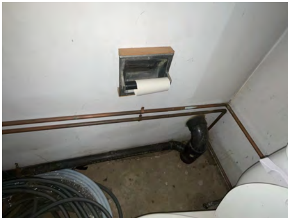
Brudenell Fire Hall #4 - D202001
