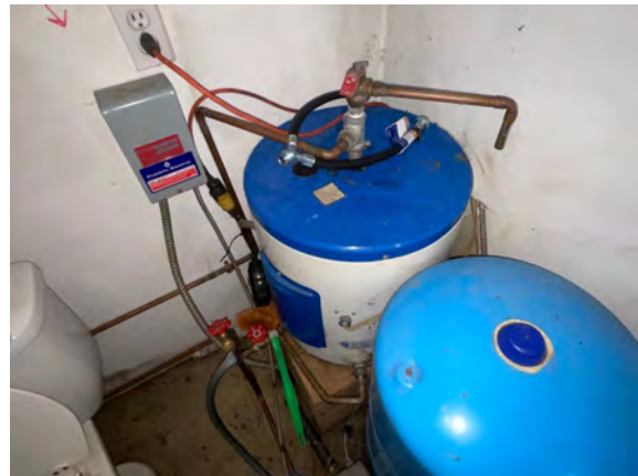
Brudenell Fire Hall #4 - D202001
