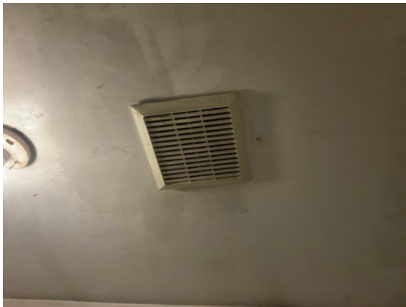
Brudenell Fire Hall #4 - D304031
